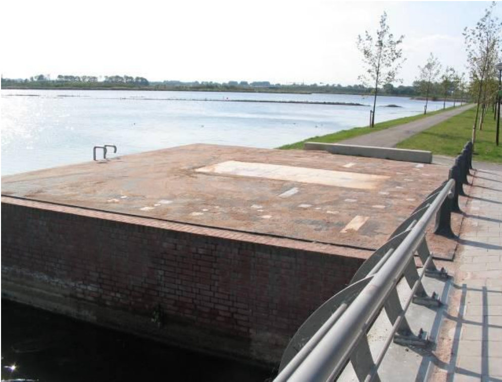
De zonnwijzer in aanbouw dd. 16 september 2009
